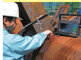
超音波検査 (溶接部)
