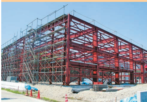
建方 (現場施工)
