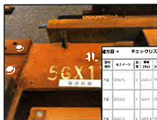
QRコードで鉄骨部材を管理した事例
