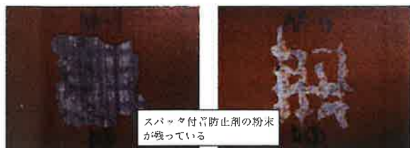
写真12 スパッタ付着防止剤 層間剥離・さび
