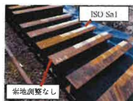
写真9 暴露 (シート養生)
