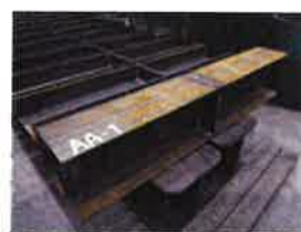
写真6 暴露前 (素地調整なし)
